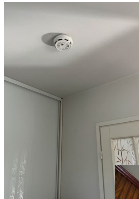
▶ Kuva 20: Palovaroitin sijoitetaan vähintään 0,5 metrin päähän seinästä.
