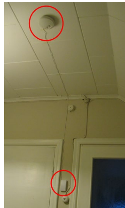
◀ Kuva 2: Palovaroittimen paristokotelo seinällä.
